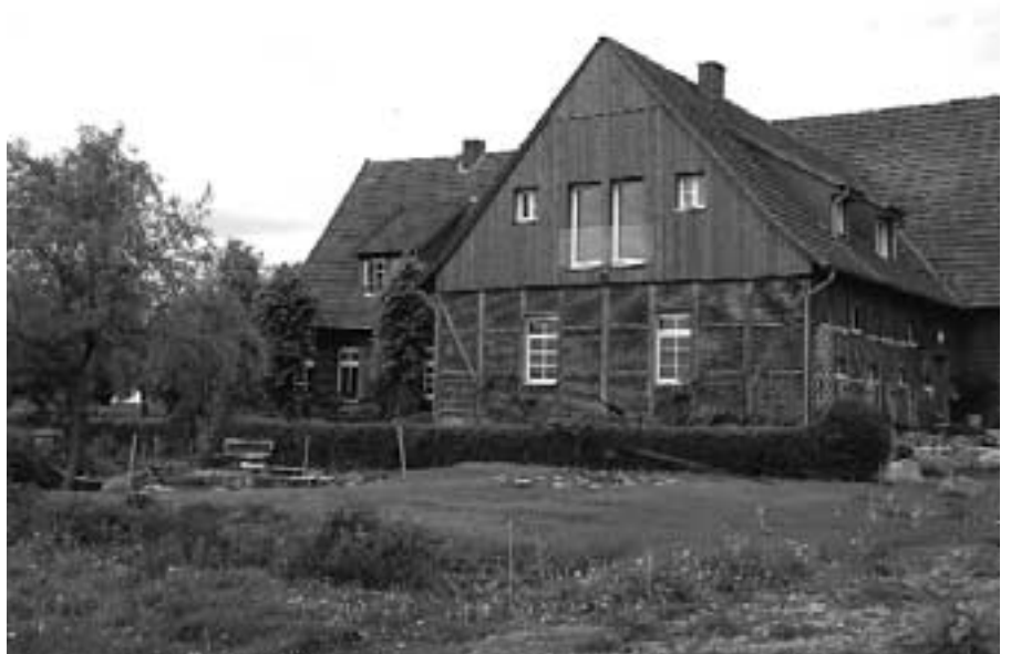
Das alte Hofgebäude Wittover ist denkmalgerecht wiederhergestellt worden.
